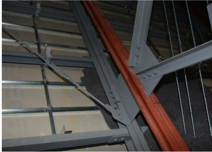
木曾文化公園文化ホール工事後の天井裏
