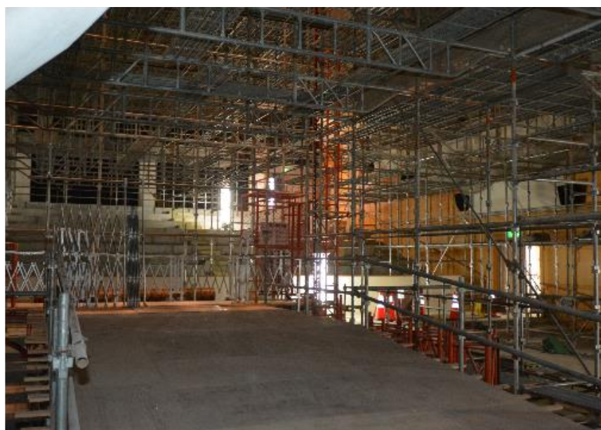
工事中の足場
